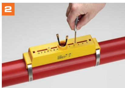
2 Fissare il binario e il gruppo sensori al tubo e rilasciare le viti di blocco dei sensori
