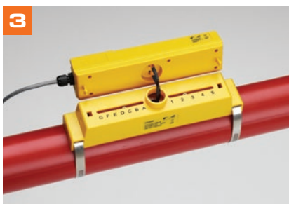
Conecte la alimentación y los sensores a la caja de componentes electrónicos
